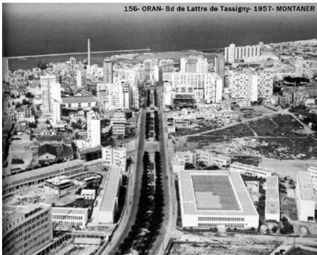
Vue générale du premier boulevard périphérique (1957). Source : http://forgalus.free.fr/
