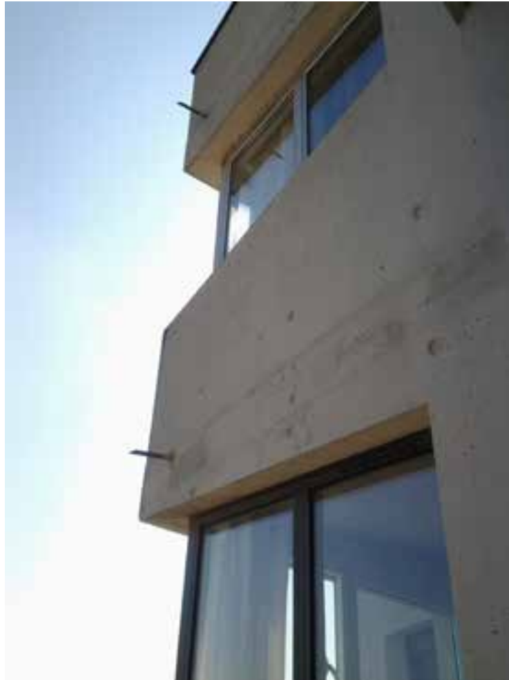
Structure architecturale angulaire de la Tour Panoramique. ©O. Legrip, 2019
