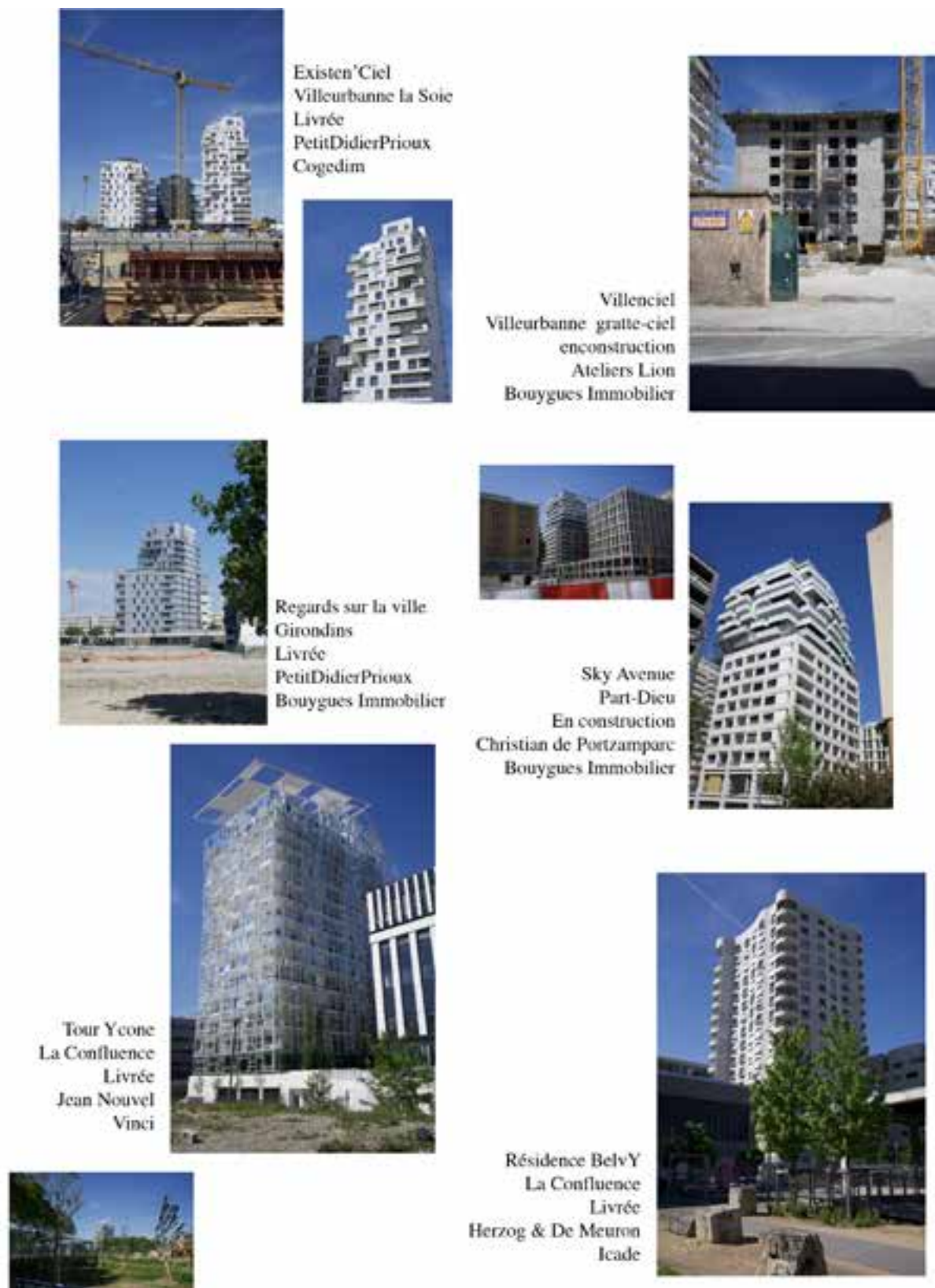
Figure 1 : Photographies des tours résidentielles de Lyon-Villeurbanne. Source : G. Mollé, 2019
