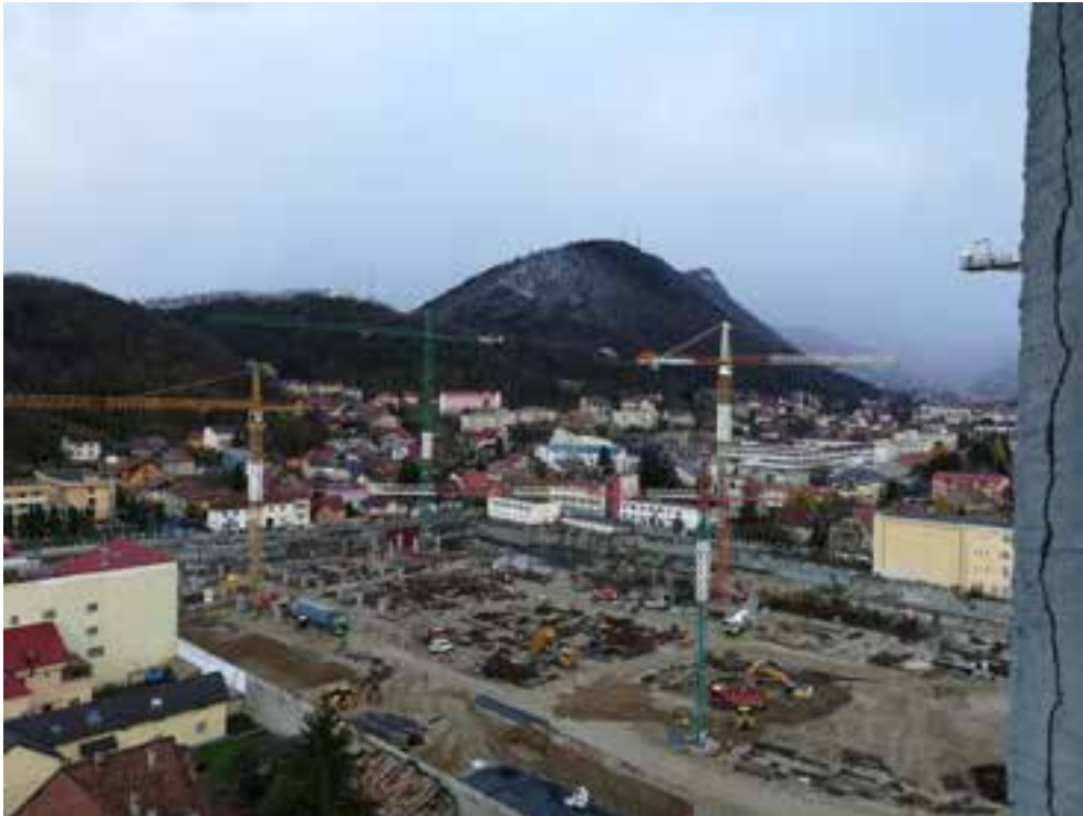
Le chantier du nouveau Mall. Photo prise depuis l'appartement de Mme S.J. 2018 ©Bianca Botea
